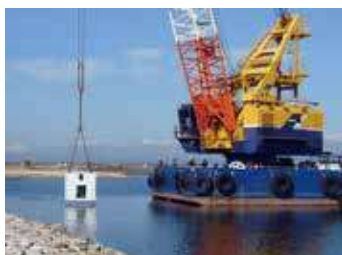
ミニエコブロックの設置状況
