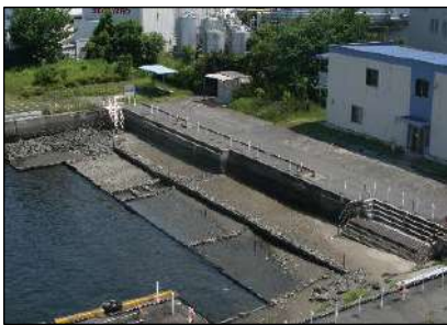
横浜港 横浜港湾空港技術調査事務所 「潮彩の渚」
