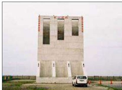
四国地方整備局 三島川之江港 直立型 エコシステム式ケーソン http://www.mlit.go.jp/chosahokoku/h19giken/program/kadai/pdf/innovation/inno3-02.pdf
