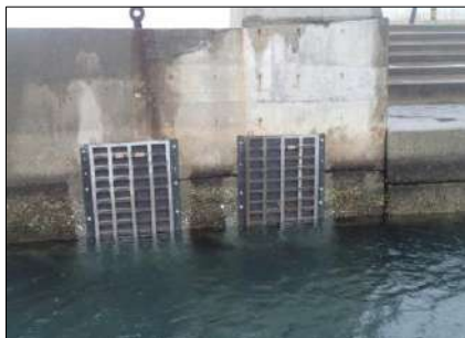
鉄製エコパネルの実験例 堺泉北港※
