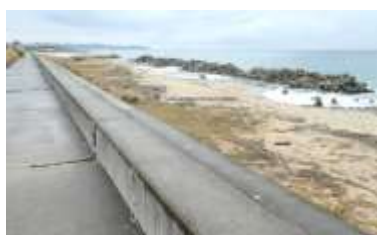
CSG 製の堤防と消波ブロック。 夏井川河口から約 500m 南付近
