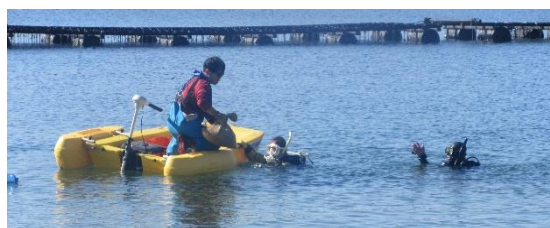
ダイバーによる播種シート・土嚢の設置作業
