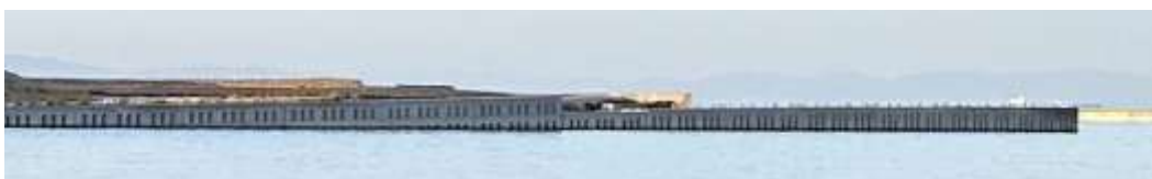
護岸部分に等間隔で孔があり、不等沈下の様子がよく分かる写真
