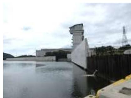
南海トラフ地震を想定した約8mの防潮堤を建設中。裏込材には高炉水砕スラグを使用。
