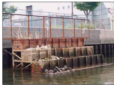
東京都曙運河（階段式） 出典：岡村ら：湾奥における生物と共生する護岸 海洋開発論文集第19巻,pp. 291-296, 2003
