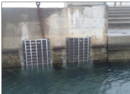
鉄製エコパネルの実験例 堺泉北港※
