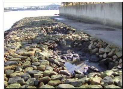
東京都曙運河（石積堤利用） 出典：岡村ら：湾奥における生物と共生する護岸 海洋開発論文集第19巻,pp. 291-296, 2003
