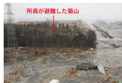
▲ 3.11 東日本大震災の大津波から従業員を守った築山 (日鐵住金建材(株) 仙台製造所)
