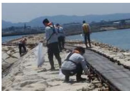
▲共和海建 G による護岸の清掃活動
