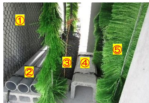
▲内部材の設置状況
