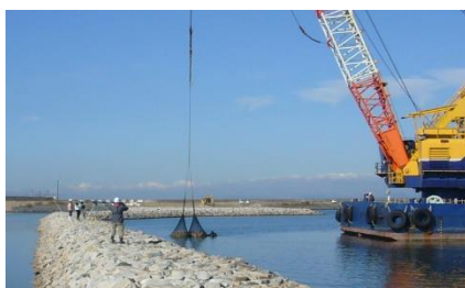
▲フィルターユニット敷設状況
