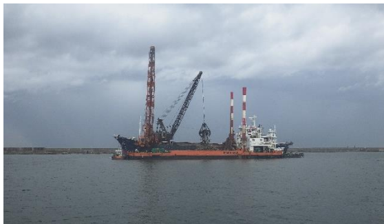
▲ 捨石瀬取り状況
