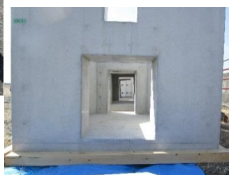
▲ 側面のスリット部
