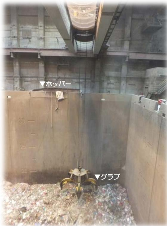
約30mの高さがある6階からごみピット上部を見学。移動中、館内でごみの臭いが感じられなかったが、それは臭気の最大の発生源であるごみピットやパッカー車からごみを投入するプラットフォームなどを密閉し、この空間から吸引した空気を焼却炉での燃焼空気として利用していることによる。
